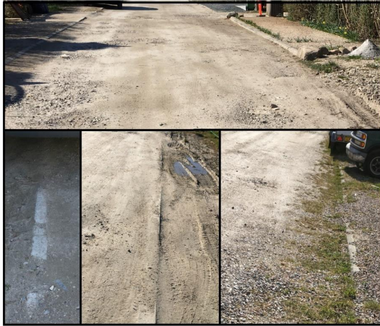
Figur 3 Billederne viser at kantstenenes tilstand er varierende - nogle er nyanlagte med lysninger på 10 cm mens andre er krakelerede og nedsunkne
